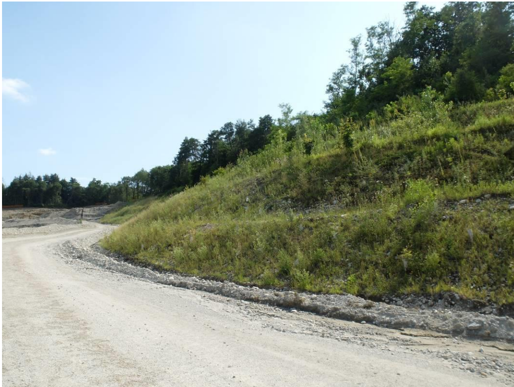
Figura 5.2. Scarpate ripristinate, nella fascia ovest di Faraona, oggetto dei rilievi.
